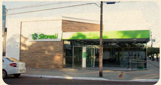
Agência Colinas do Tocantins - Colinas do Tocantins / TO Av Pedro Ludovico Teixeira, S/N Q. 81, Lote.1 - Centro
